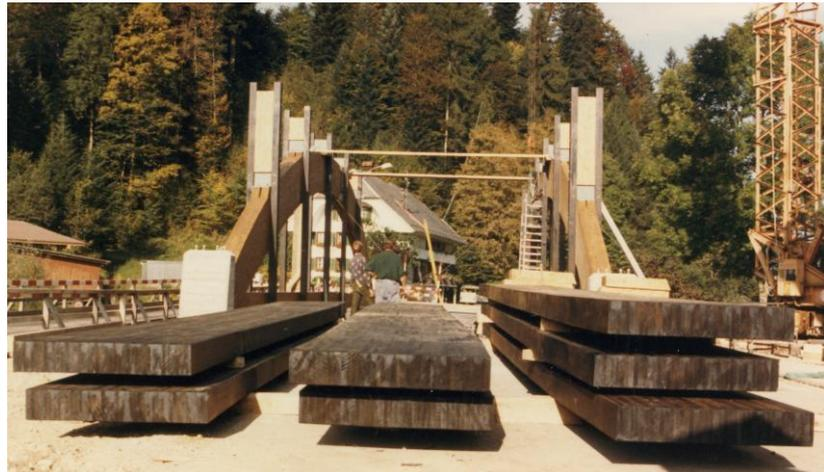
Abbildung 4a und 4b: Strassenbrücke Eggwil: Hängepfosten und Querträger in BSH-Buche
