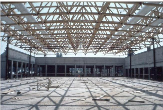
**Abbildung 3:** Tragkonstruktion Arbon Raumfachwerk mit Stäben aus BSH
