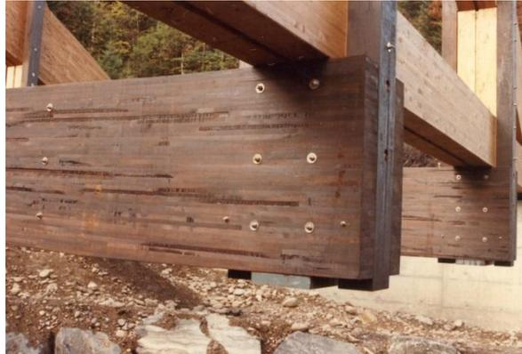
**Abbildung 7:** Verbindung Hängepfosten / Querträger Portalrahmen
