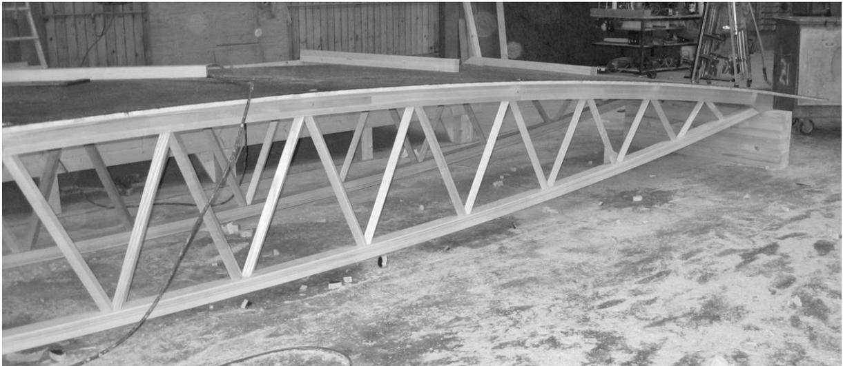
Abbildung 19: Fischbauchträger für Fussgängerpasserelle (n'H / 2009); Druckgurt aus BSH-Esche; Zuggurt aus FSH-Esche; Diagonalen aus Schnittholz Esche. Knoten verschraubt (Ausnahme Auflagerknoten).
