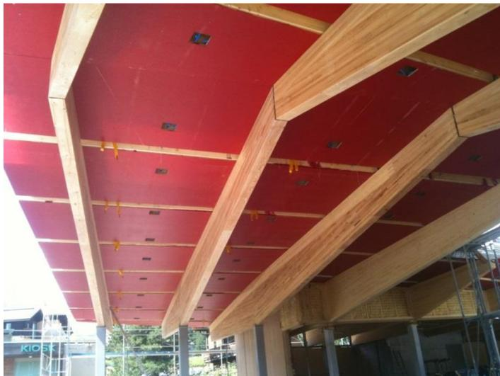
Abbildung 7: Gelenkig abgewinkelter Firststoss der ersten vier Binderachsen
